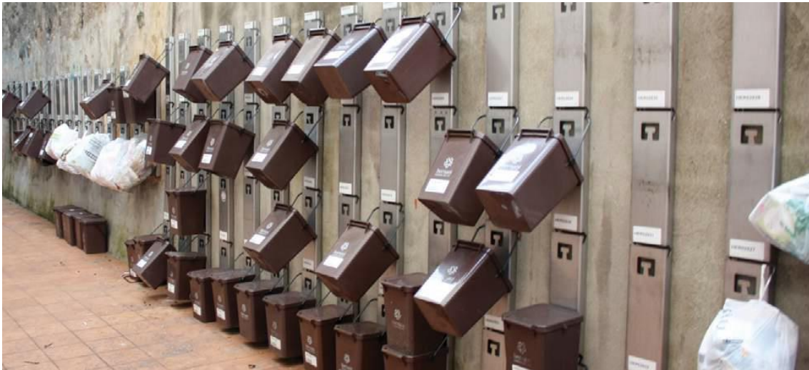
Figura 1 – Sistema de recogida puerta a puerta. Fuente: Amigos de la Tierra (2016)
